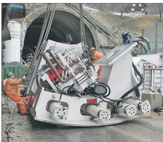
Links hebt der Riesenkran ein Antriebsmotoren-Teil vom Tieflader. Rechts das Teil vor dem Portal. Zum Grössenvergleich der Arbeiter links im grünen Helm.
