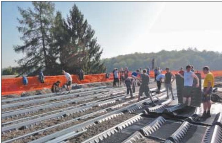
Oben: Die Lehrlinge im Einsatz auf dem Riniker Turnhallendach. Sie montieren die Schienen auf die mit Kies stabilisierte Plastikunterlage. Unten links Kurt Wernli, bei der Jost Brugg AG verantwortlich fürs Solargehäuse, hinter zwei der Solarzellen-Elemente. Rechts wird gereicht, gebohrt und dann genietet, so dass die Montageschienen stabilisiert sind.
