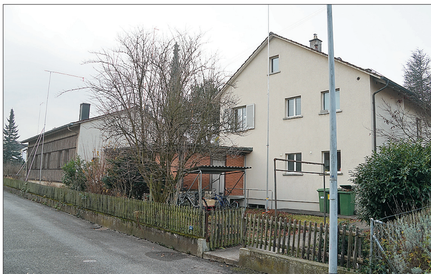
Die Liegenschaft Habsburgerstrasse 20 vom Enzianweg aus gesehen. Die Gewerbaute der ehemaligen Gipserei wird abgebrochen. Im alten Haus wohnt bereits eine Gruppe vom Kinderheim Brugg.
